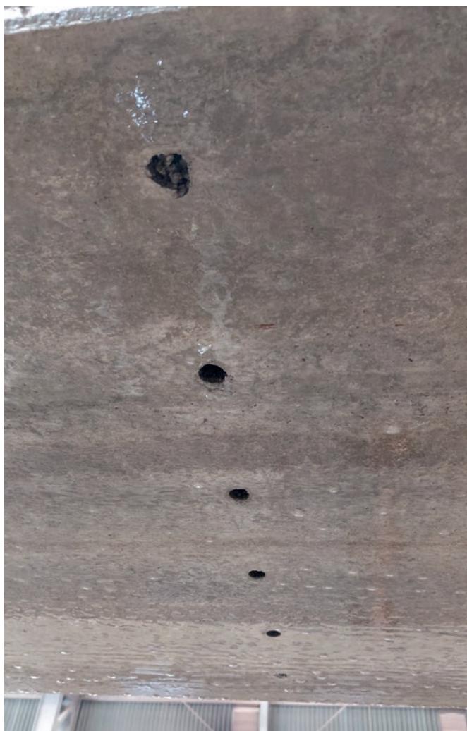
Fori di drenaggio visibili sull'intradosso dei pannelli alveolari
