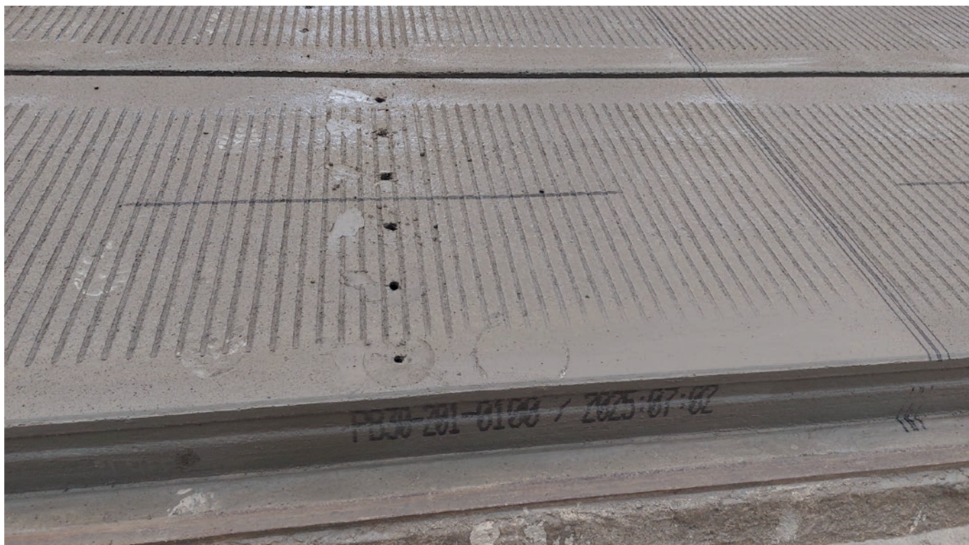
Pannelli alveolari con marcatura e fori di drenaggio immediatamente dopo il getto
